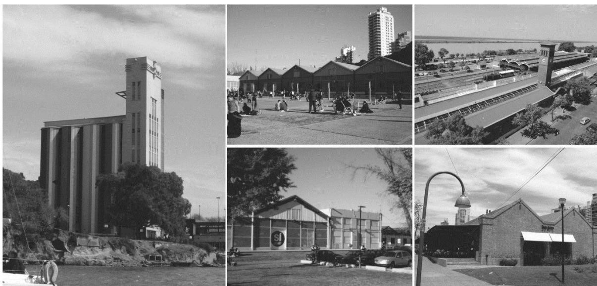
Figura 8. Reconversión del patrimonio ferro-portuario en la costa central de Rosario: Silos Davis, galpones portuarios, estación Rosario Central y galpón N°10. Fuente: Fotografías de la autora.
