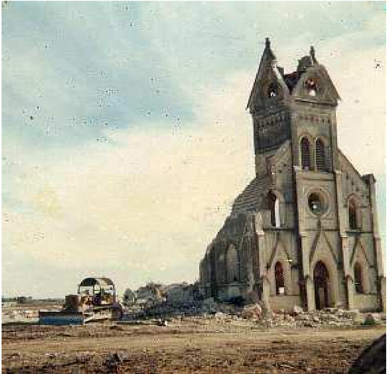
Demolición de la Iglesia, última estructura en pie de la vieja ciudad de Federación.
