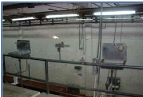
**Imagen III. 20:** Piletas para lavado y esterilización por puesto
