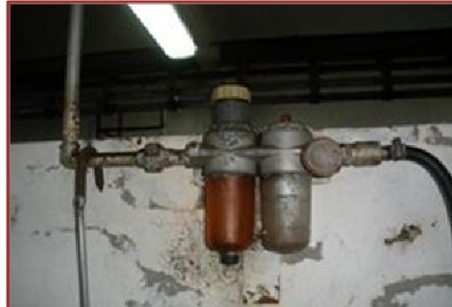
*Imagen III. 11:* Filtro de aire comprimido
