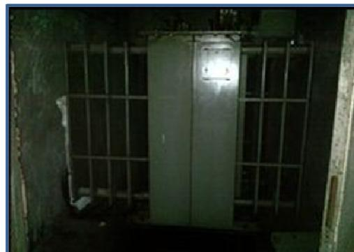
*Imagen III. 6:* Transformador de 13,2 a 380
