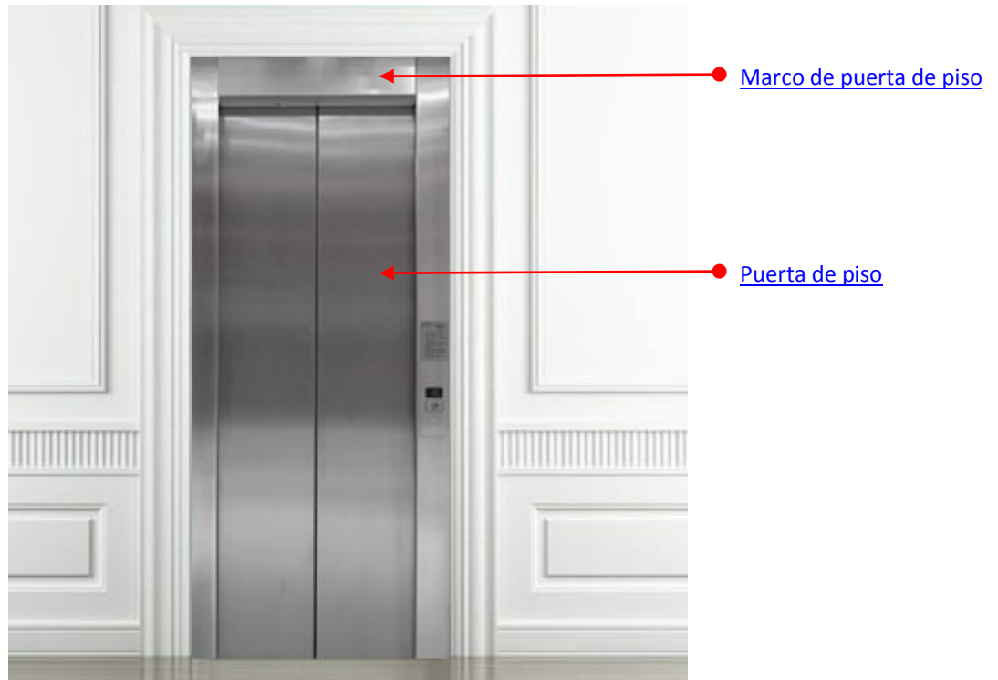
Imagen 24. Puerta de Piso del Ascensor
