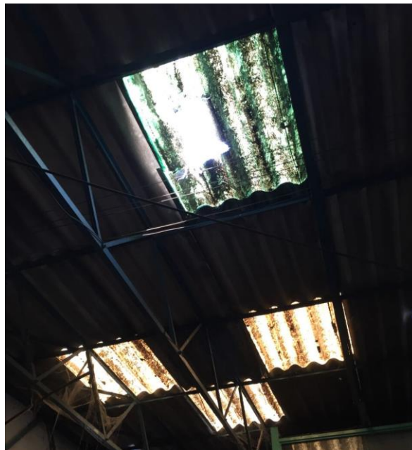
Imagen 43. Techo de la Planta
