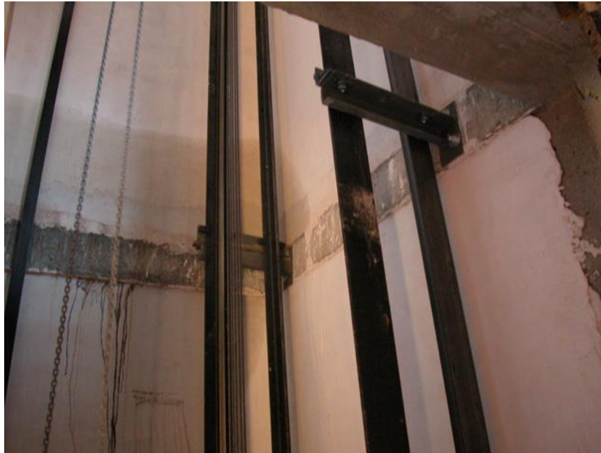
Imagen 22. Guías de un ascensor
