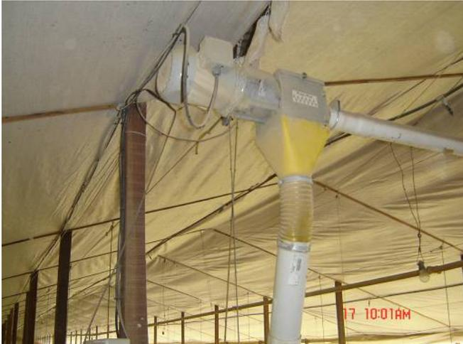
Foto C23) Caño del silo visto desde abajo del galpón, con las dos bajadas.
