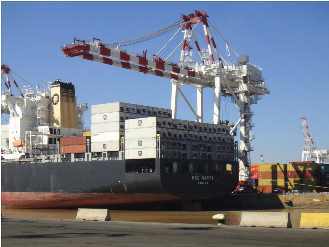
FIGURA 9 – Ship to Shore Gantry Crane o Portainer en Terminales Río de la Plata (DP World), Buenos Aires, Argentina.
