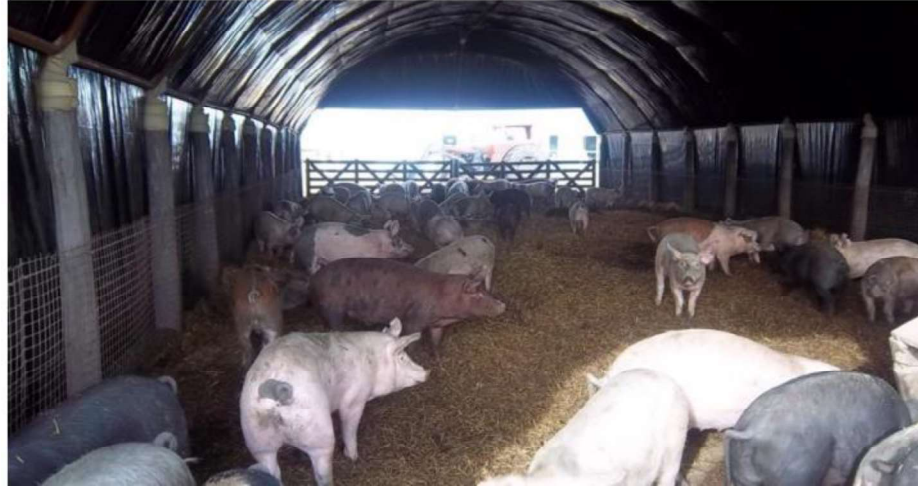
Figura 7: sistema de cama profunda con túnel de viento. Unidad demostrativa agrícola porcina del INTA EEA Marcos Juárez
