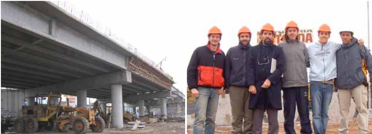
Alumnos de Ingeniería Civil recorren el emprendimiento en el cruce de las rutas Provincial N° 4 y Nacional N° 3, en La Matanza.
