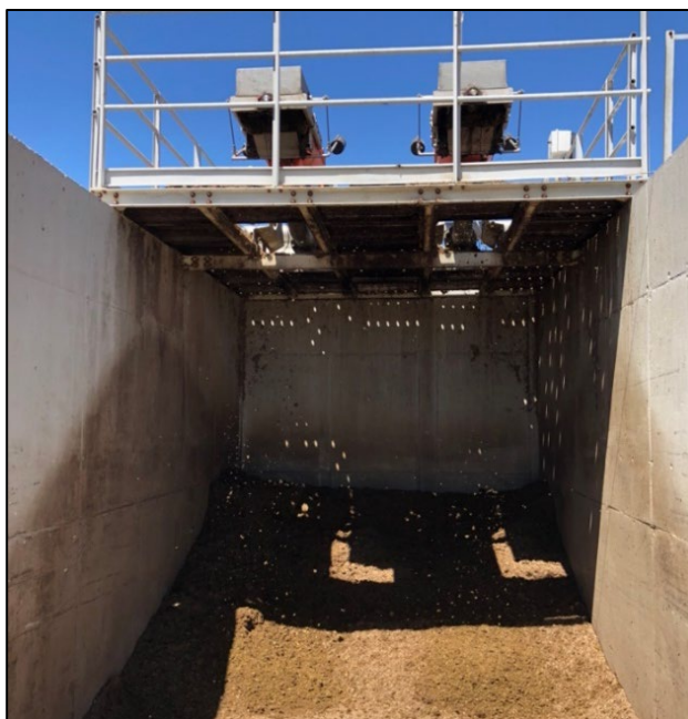
Figura 16. Tornillo-prensa: encargado de separar la fracción sólida y líquida del digerido porcino.
