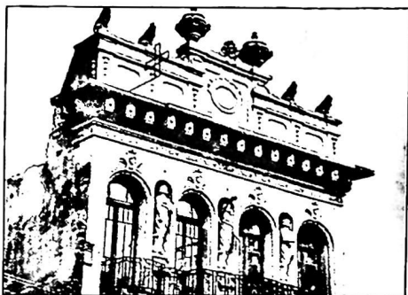
Ilustración 13. FARMACIA L'AIGLON. Av. Nuestra Señora del Rosario 107, Saladillo. El edificio quedó afectado por la traza de las obras del puente y bajo nivel Av. Lucero y más allá de la declaratoria de valor arquitectónico y urbanístico de su fachada 3 , ésta fue definitivamente demolida a comienzos de 1987.
