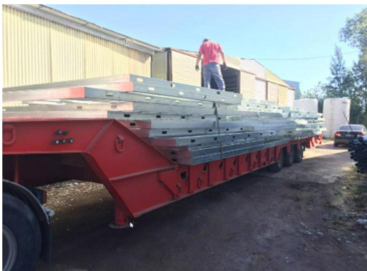
Figura 5: Traslado de paneles de Steel Frame en un camión.
