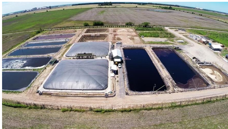
Ilustración 6: Planta de tratamiento y producción de biogás - SOLAMB.
