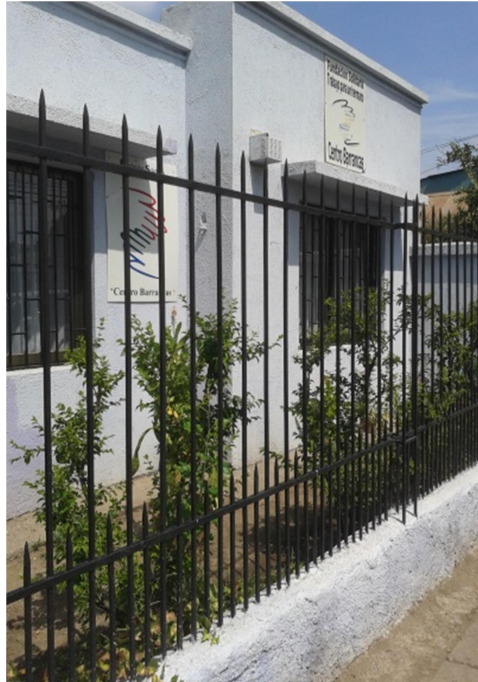
Centro de emprendimiento y desarrollo Barrancas
