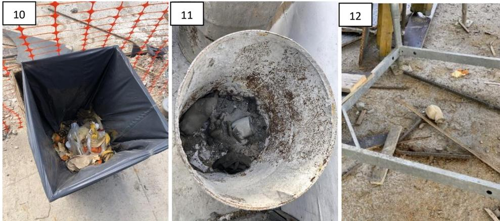
**6. Recortes de encofrados de fenólico.** Se van acumulando directamente sobre el piso. Los recortes más grandes son recuperados por los operarios, que se acercan a la pila buscando piezas según el tamaño y forma que les sirva para reutilizar. Los recortes más pequeños se terminan descartando.
