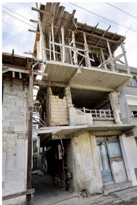
Figura 3: Construcción por esfuerzo propio en el barrio céntrico del Cerro
