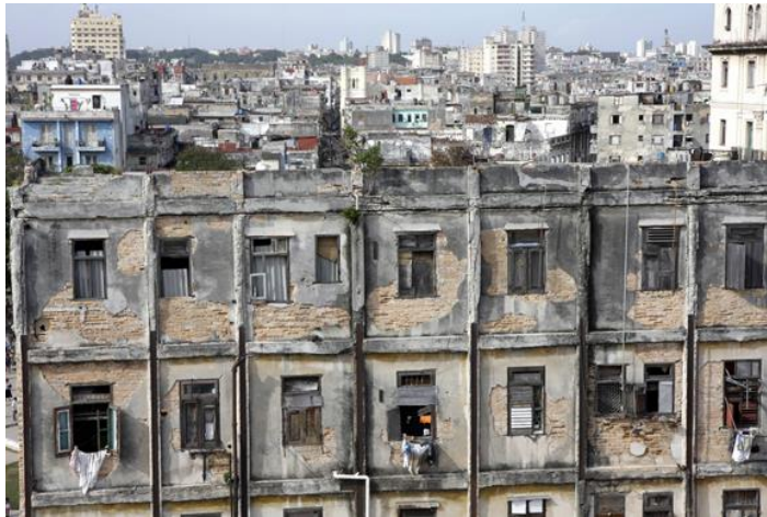
Figura 4: Imagen de un edificio de viviendas muy deteriorado cerca del Capitolio
